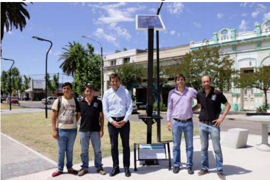
Imagen 12. Instalación de cargador solar en Skate Park.
